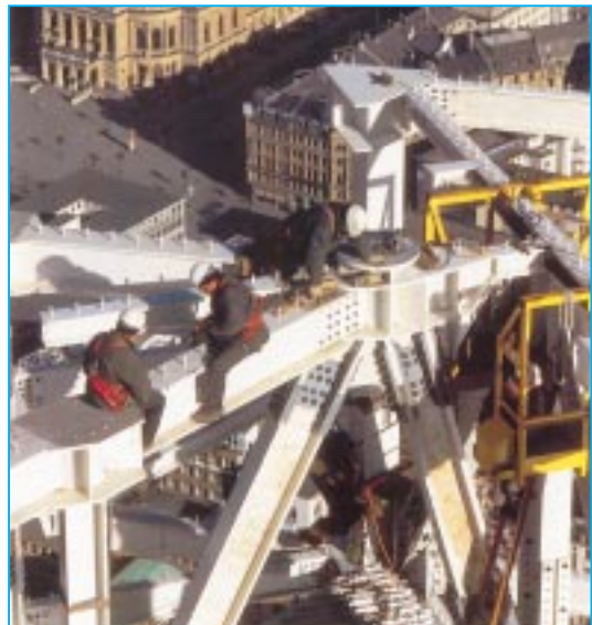
2 Praktische Ausführung von SLV-Verbindungen
